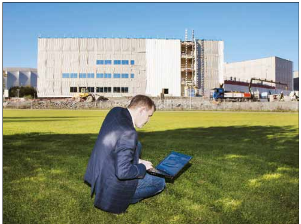
BIM EFFEKT: BIM og åpenBIM har gitt effekt på Aker Solutions nye kontorbygg på Fornebu. FOTO: Åsa Maria Mikkelsen/STUDIO B13
